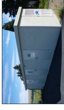
Exemple de poste de livraison en préfabriqué
